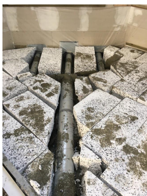
De ventilatieinstallatie is onzichtbaar opgenomen in de kerkzaal
