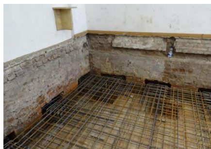
Voorbeeld inkassen betonvloer in kerk- muur
